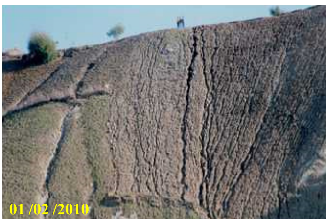
Photo 1: Érosion ravinante après un événement pluviométriques exceptionnel
