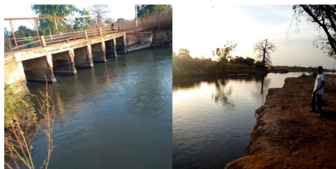
Photo 4: Barrage de Diopcounda: principal ouvrage de maîtrise de la salinité dans le bassin versant du Soumboundou (Cliché, 2023)
