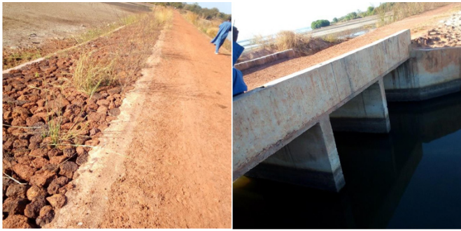
Photo 5: Digue anti-sel en construction à Manconomba dans le cadre du projet PROVAL-CV/PARIIS (Banque mondiale) (Cliché, 2023)
