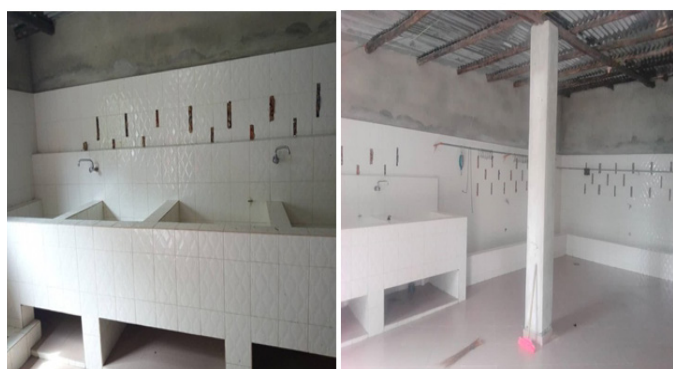
Figure 3: Bâtiment d'abattage satisfaisant
